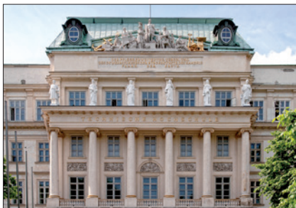
TECHNISCHE UNIVERSITÄT WIEN, HAUPTGEBÄUDE © TU Wien
